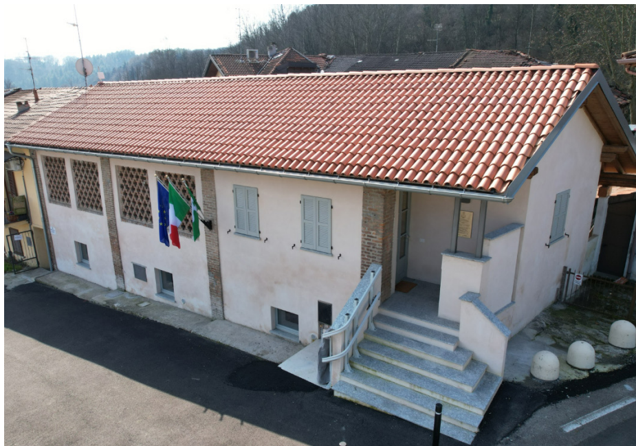
La Cascina Emanuela Loi – confiscata alla criminalità organizzata e ristrutturata dal nostro Comune
